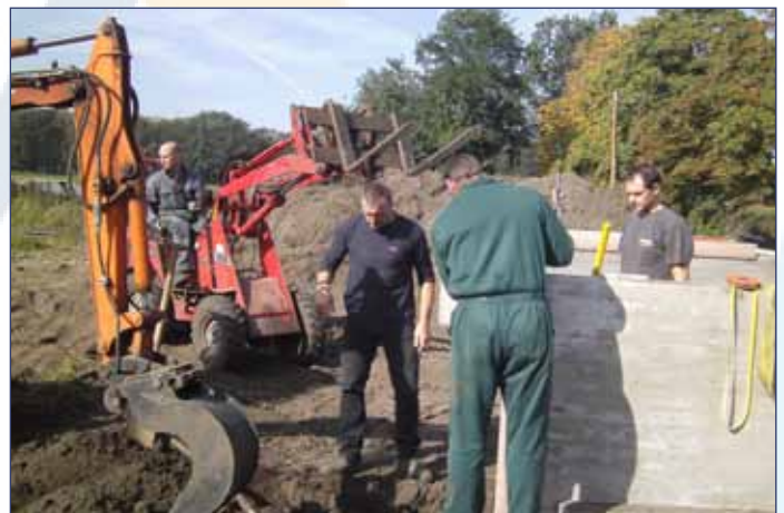
Aanleg van de composteerplaats © Immerthoeve
